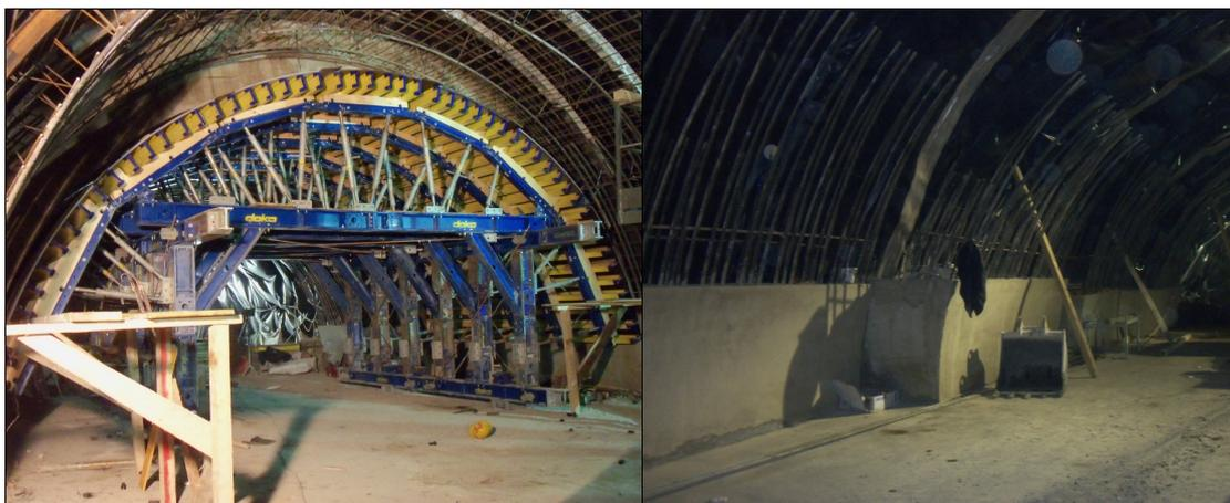
**Figura 6. Particolare del cassero di calotta a sinistra; a destra si nota la trave a sostegno del getto di calotta)**
