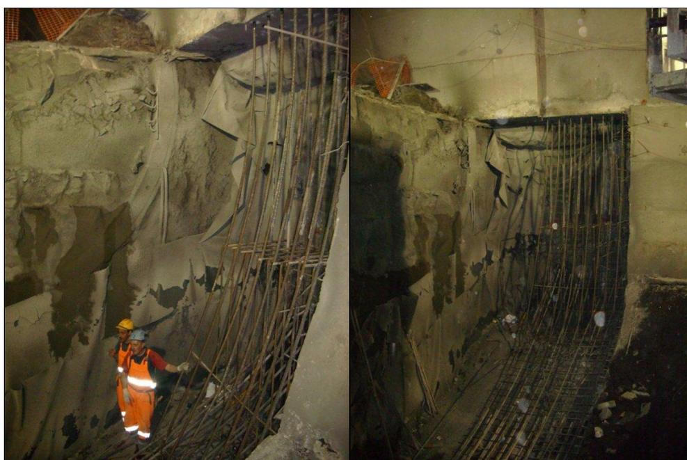
**Figura 7. Particolari dell'armatura di murette e dell'arco rovescio al di sotto del getto di calotta di prima fase e del getto di calotta di prima fase**
