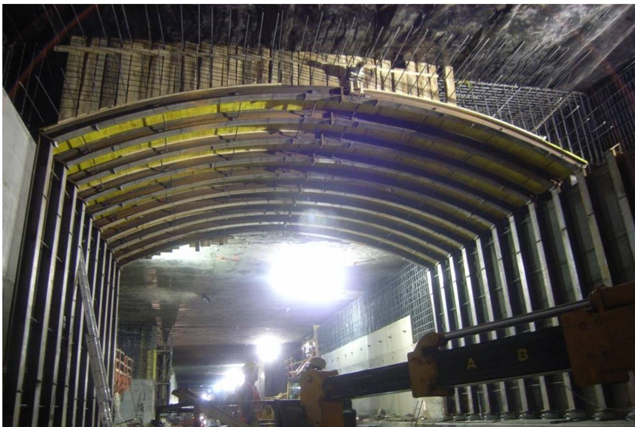
*Fig. 15 – Centine a sostegno del cassero dello scatolare*
