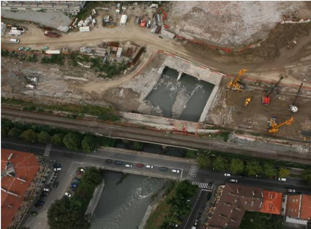
Fig. 10 – Demolizione della tombinatura del Fiume Dora
